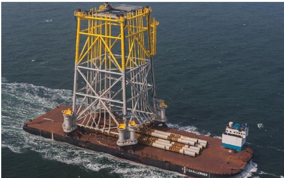
Figure 11 : Exemple de transports de pieux et de la sous structure sur une barge. Source : DNV
