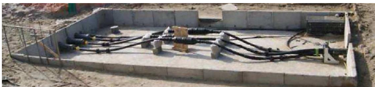
Figure 6 : Exemple d'une jonction d'atterrissage avant son comblement
