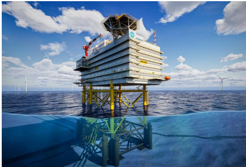
Figure 7 : Exemple de plateforme électrique en mer : RTE
