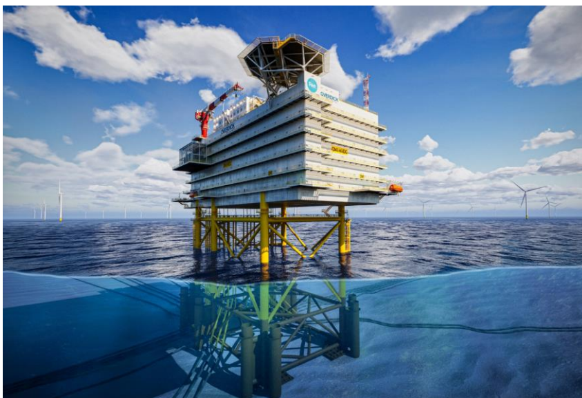
Figure 14 : Exemple de plateforme électrique en mer : RTE
