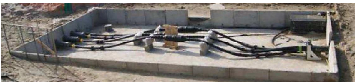
Figure 16 : Chambre de jonction d'atterpage avant comblement. Source : RTE
