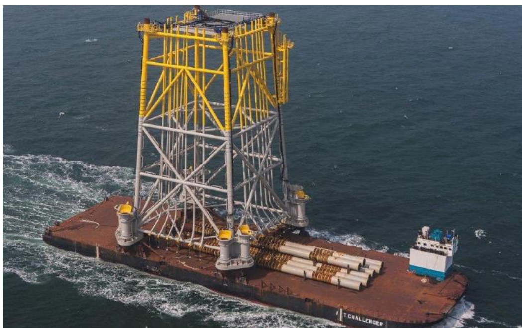
Figure 17 : Exemple de transports de pieux et de la sous structure sur une barge. Source : DNV
