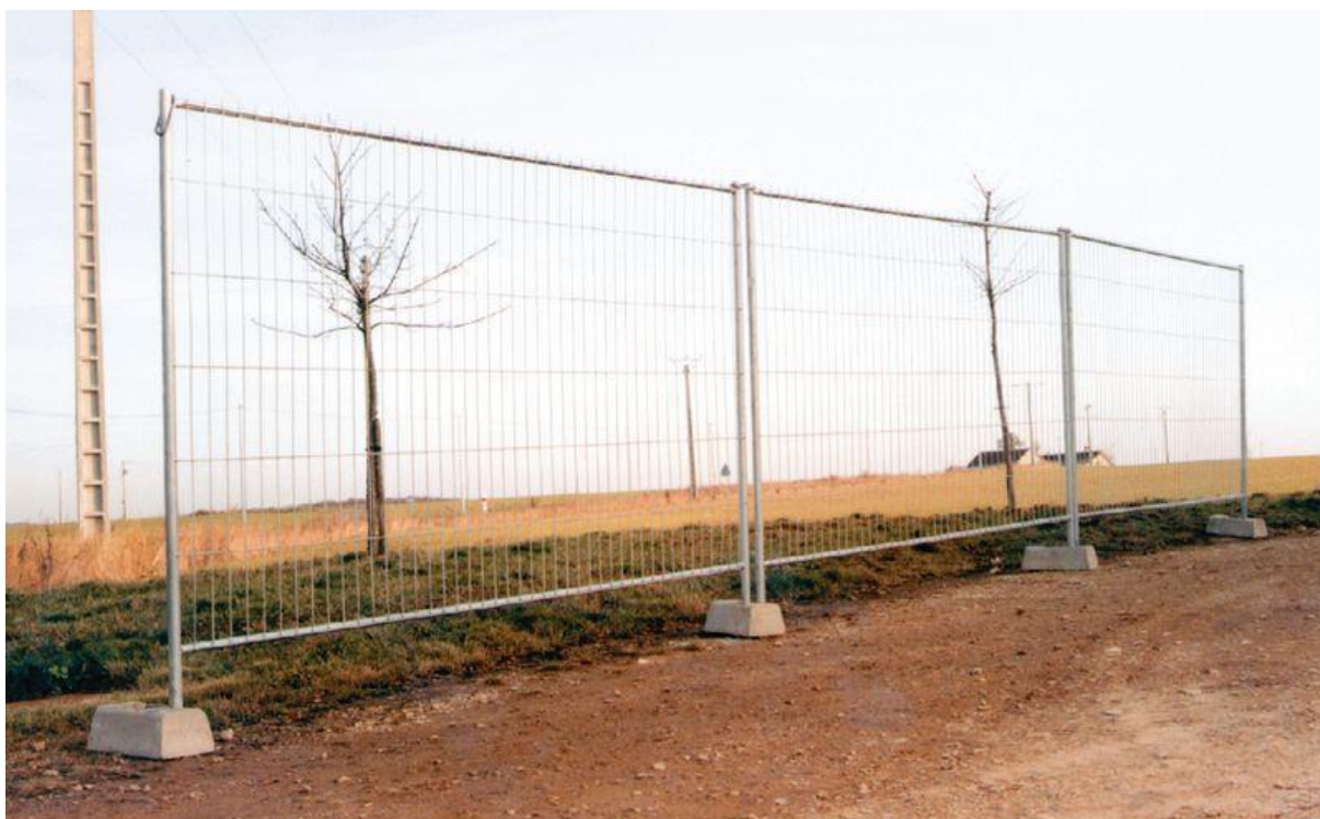
Figure 15 : Exemple de barrière heras pour clôturer le chantier. Source : RTE.
