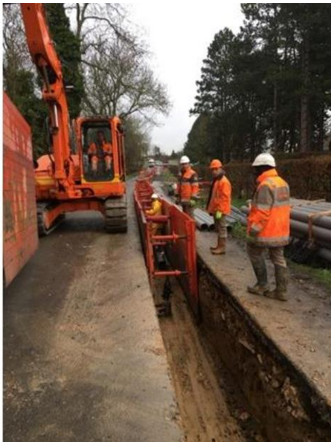
Figure 12 : Exemple de chantier sous la chaussée. Source : RTE.
