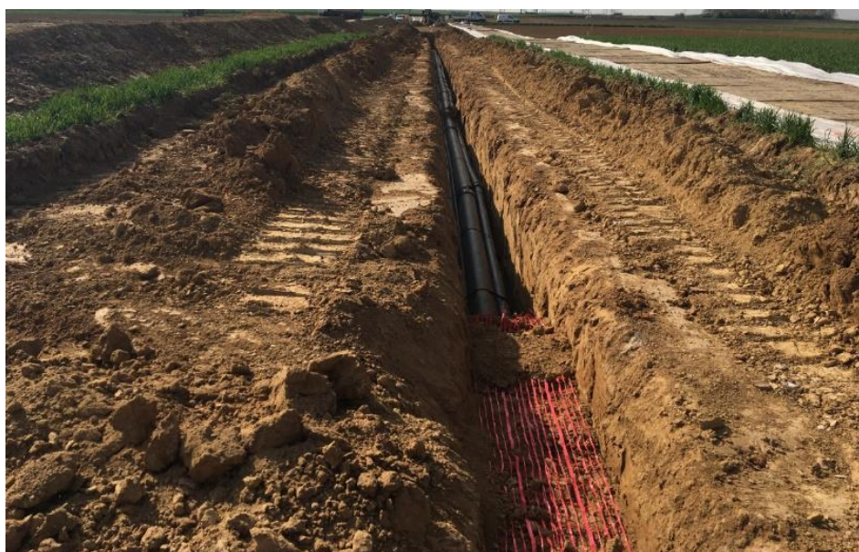
Figure 11 : Pose d'une liaison souterraine en fourreaux PEHD en zone agricole. Source : RTE
