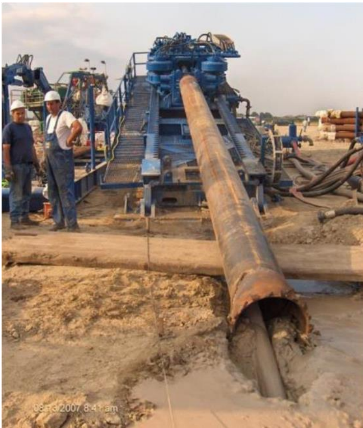
Figure 14 : Représentation de la technique du forage dirigé. Source : RTE
