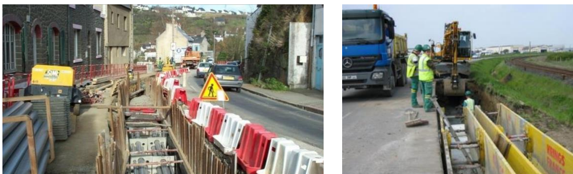
Figure 10 : Pose d'une liaison souterraine en fourreaux PVC béton sous et en bordure de voirie. Source : RTE
