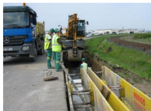
Figure 6 : Pose de liaison souterraine PVC béton à deux circuits sous et en bordure de voirie. Source : RTE
