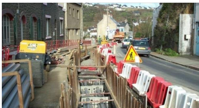
Figure 6 : Pose de liaison souterraine PVC béton à deux circuits sous et en bordure de voirie. Source : RTE
