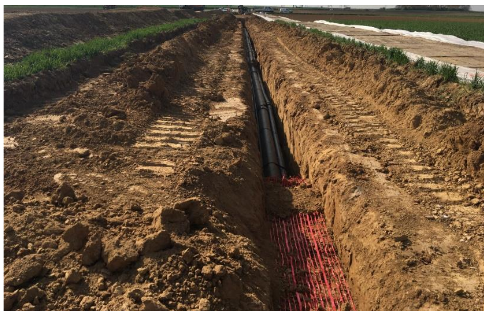
Figure 7 : Pose d'une liaison souterraine 225 kV en fourreaux PEHD en zone agricole. Source : RTE
