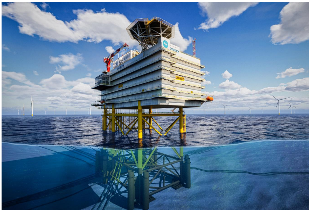
Figure 10 : Exemple de plateforme électrique en mer. Source RTE
