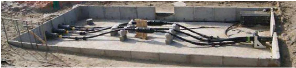
Figure 9 : Exemple d'une jonction d'atterrage avant son comblement. Source : RTE
