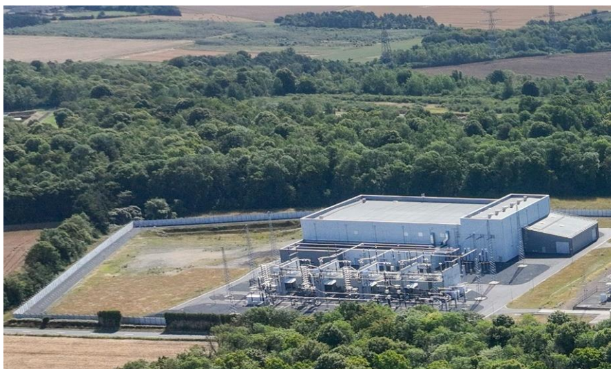
Figure 11 : Exemple d'une station de conversion. Source : RTE
