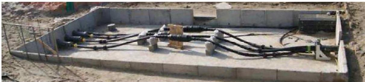
*Figure 9 : Chambre de jonction d'atterrage avant comblement. Source : RTE*
