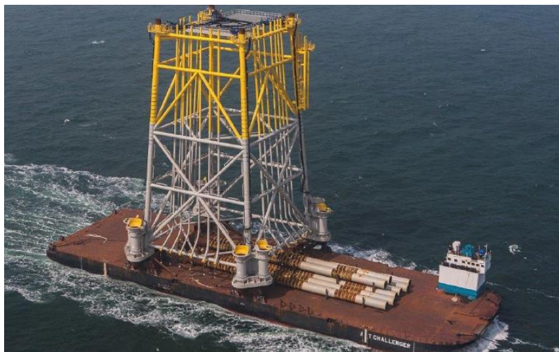
Figure 7 : Exemple de transports de pieux et de la sous-structure sur une barge. Source : DNV
