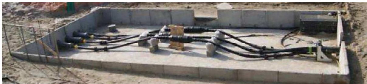
Figure 4 : Exemple d'une chambre d'atterrage avant son comblement
