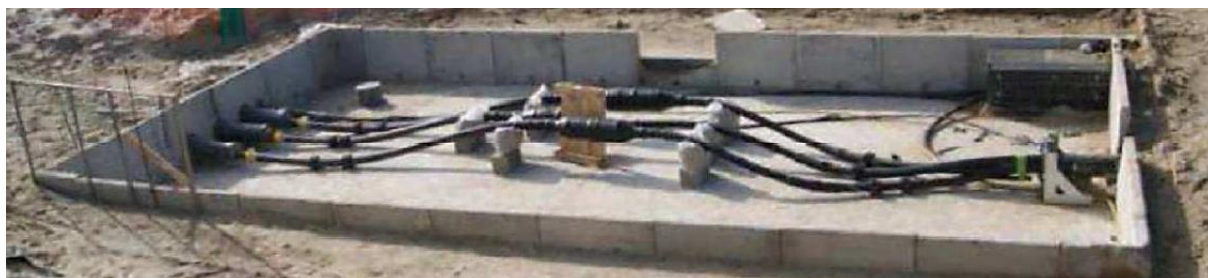
Figure 5 : Exemple d'une chambre d'atterrage avant son comblement
