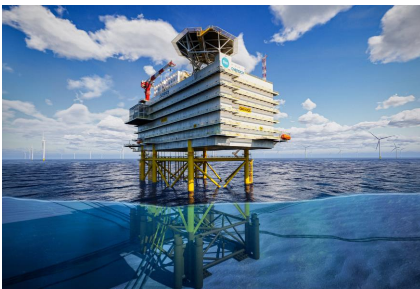
Figure 10 : Exemple de plateforme électrique en mer : RTE
