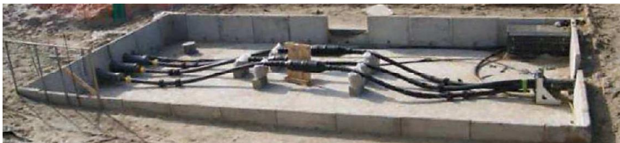
Figure 13 : Chambre de jonction d'atterrage avant comblement. Source : RTE
