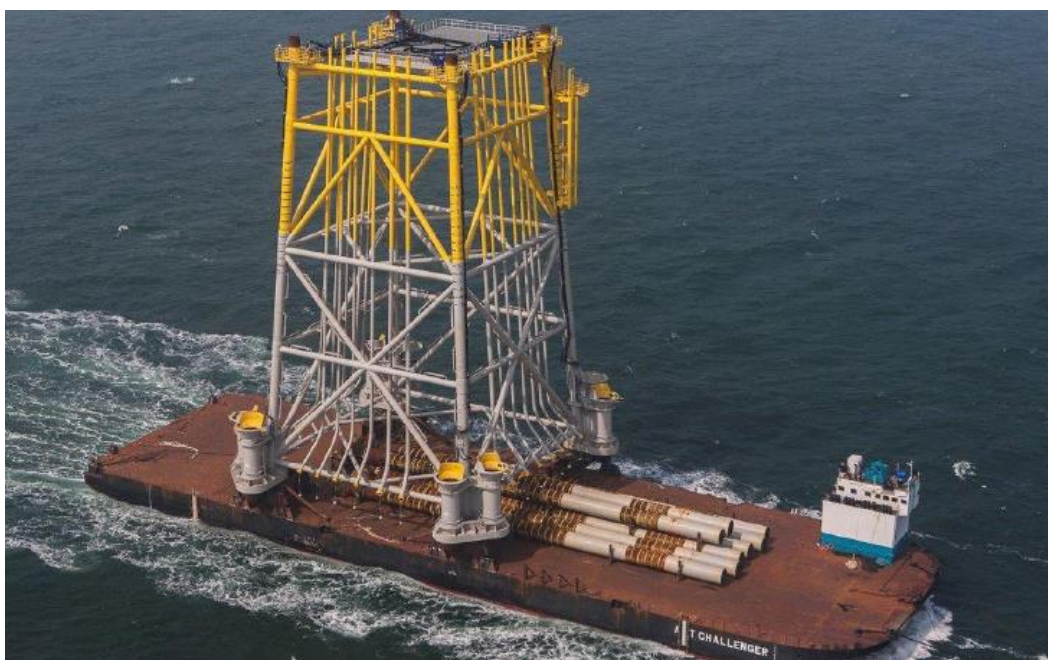
Figure 12 : Exemple de transports de pieux et de la sous structure sur une barge. Source : DNV
