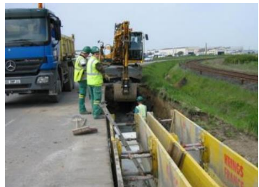
Figure 30 : Pose de liaison souterraine PVC béton à deux circuits sous et en bordure de voirie. Source : RTE
