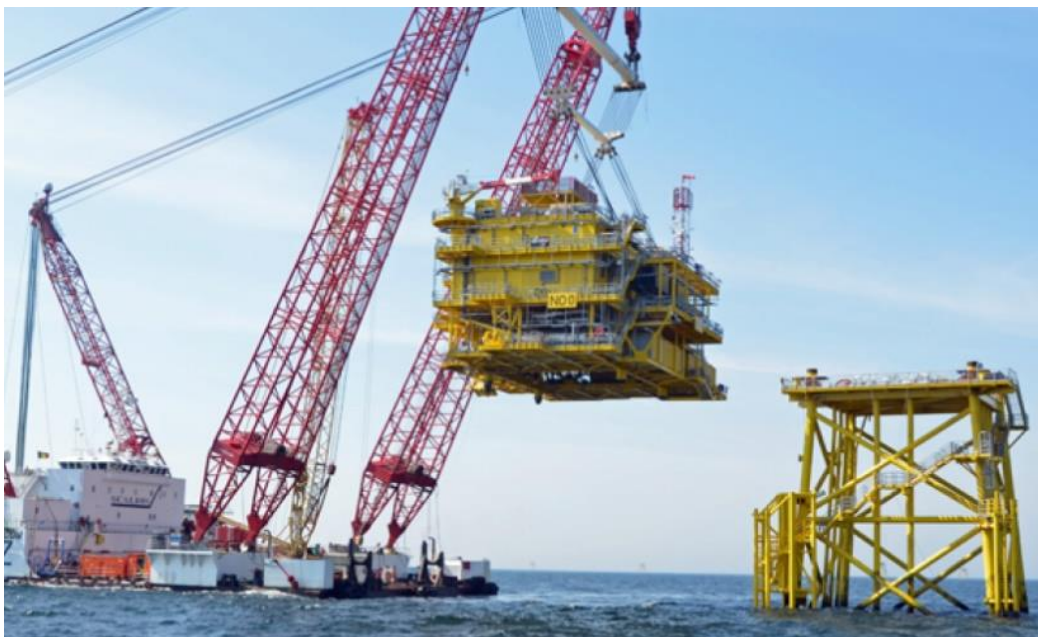
Figure 15 : Exemple d'installation d'une superstructure. Source : RTE
