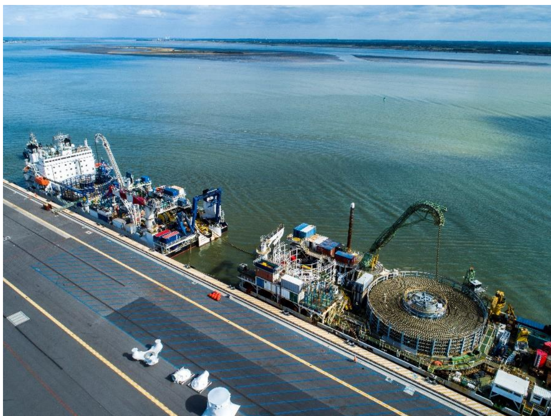
Figure 16 : Exemple d'opération de transfert de câble du navire de transport vers un navire câblé. Source : RTE - chantier de Saint-Nazaire
