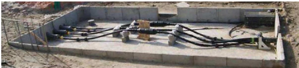
Figure 5 : Chambre de jonction d'atterrage avant comblement. Source : RTE
