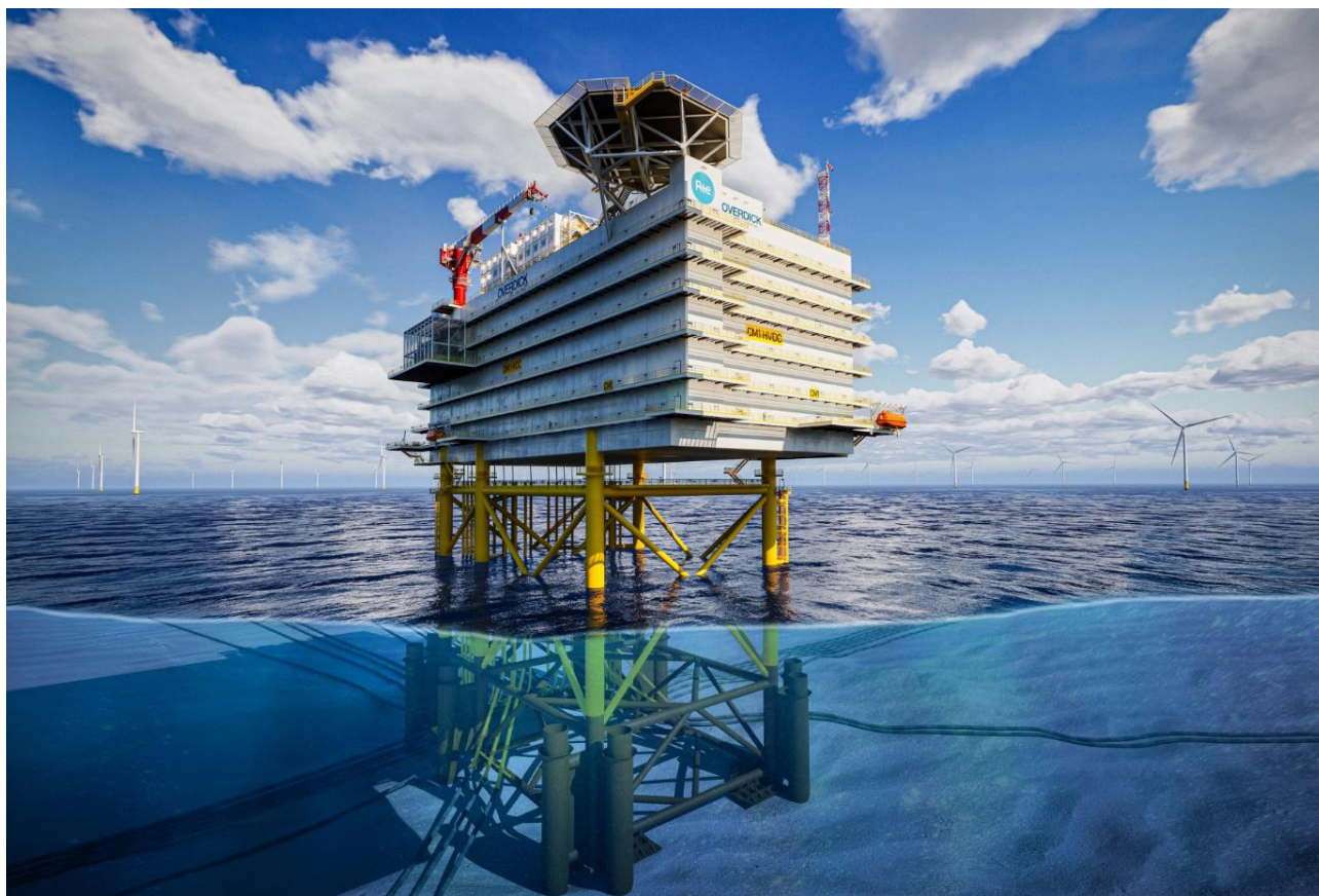
Figure 2 : Exemple de plateforme électrique en mer. Source : RTE
