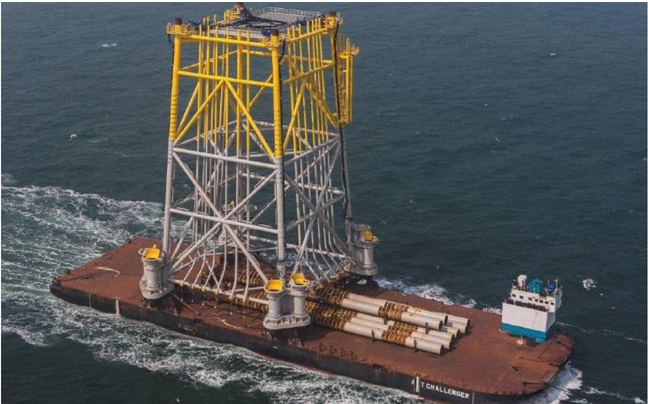
Figure 13 : Exemple de transports de pieux et de la sous-structure sur une barge. Source : DNV
