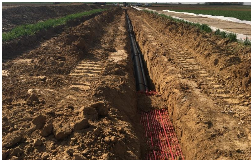
Figure 30 : Pose de liaison souterraine PVC béton à deux circuits sous et en bordure de voirie. Source : RTE
