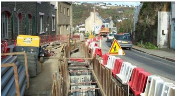
Figure 30 : Pose de liaison souterraine PVC béton à deux circuits sous et en bordure de voirie. Source : RTE
