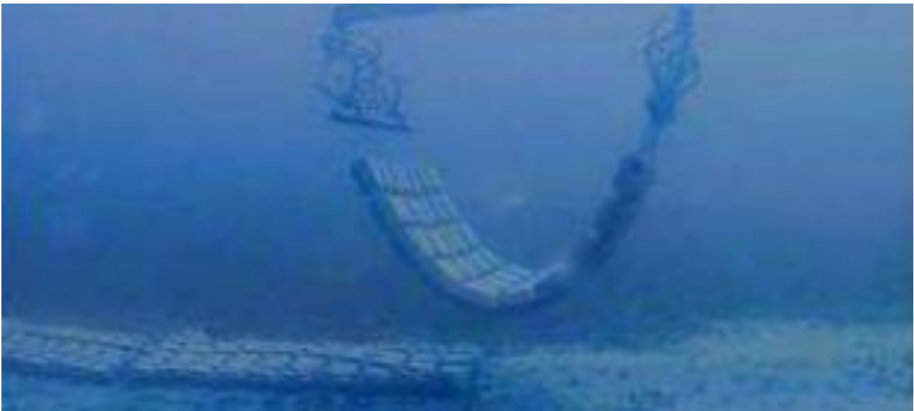
Figure 22 : Photo d'une pose d'un matelas béton sur un câble sous-marin. Source : RTE
