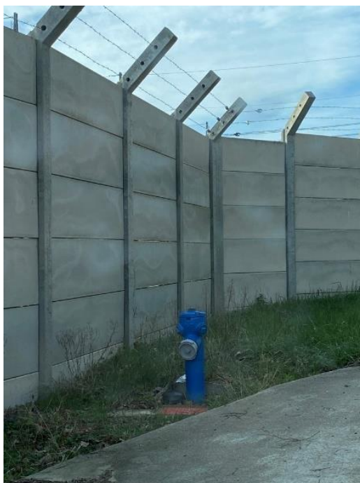
Figure 19 : Exemple d'une clôture en palplanche béton
