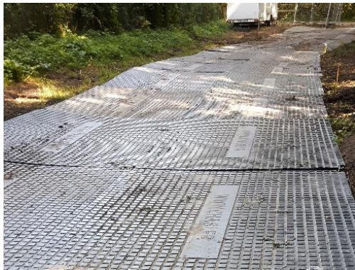
Figure 10 : Exemple de platelage sur zones humides – Source : Canal Seine-Nord Europe
