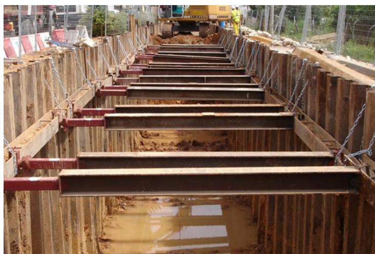
Figure 7 : Exemple de palplanches lors d'un rabattement de nappe
