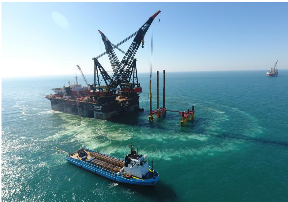
Figure 6 : Exemple de doubles rideaux de bulles durant l'installation d'un jacket (site : Offshore Substation Installation | Heerema)
