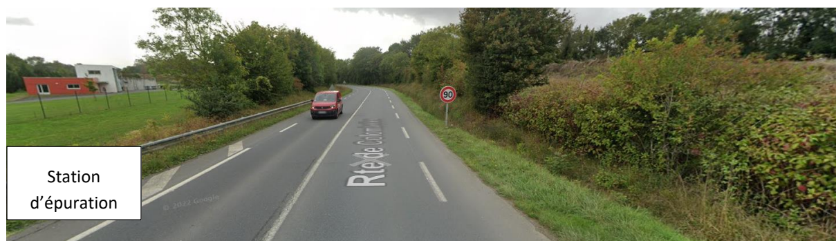
Figure 2 : Vue sur la station d'épuration. Source : Google street view.
